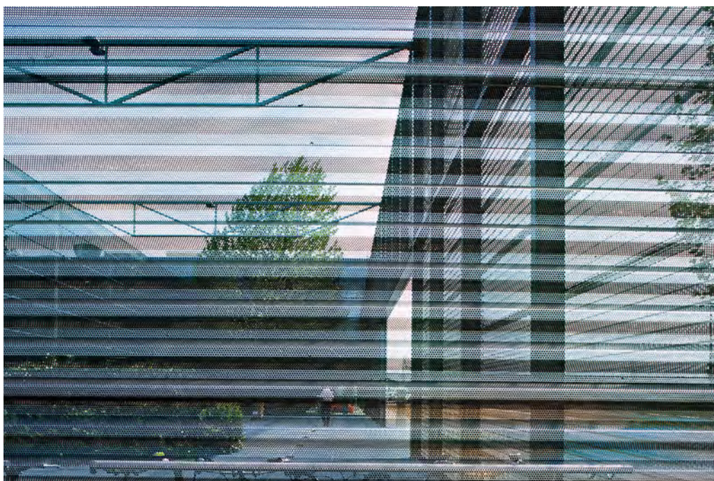
Na lotnisku Charles-de-Gaulle w Paryżu w hali odlotów, do ochrony wnętrza przed słońcem zastosowano trapezową blachę ze stali nierdzewnej z 68 mm perforacją, którą zamontowano na zewnątrz oszklenia konstrukcji.
